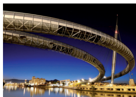
PESCARA - IL PONTE SUL MARE
